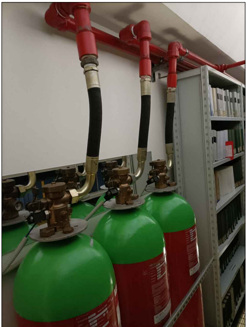
02 | Foto Gruppo di 3 bombole di gas di spegnimento
