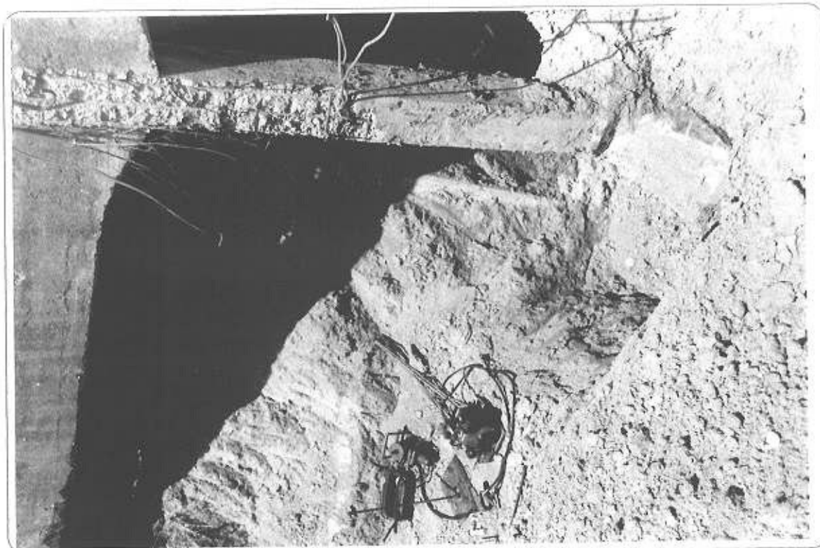
particolare di plinto - testa pali della struttura in elevazione
