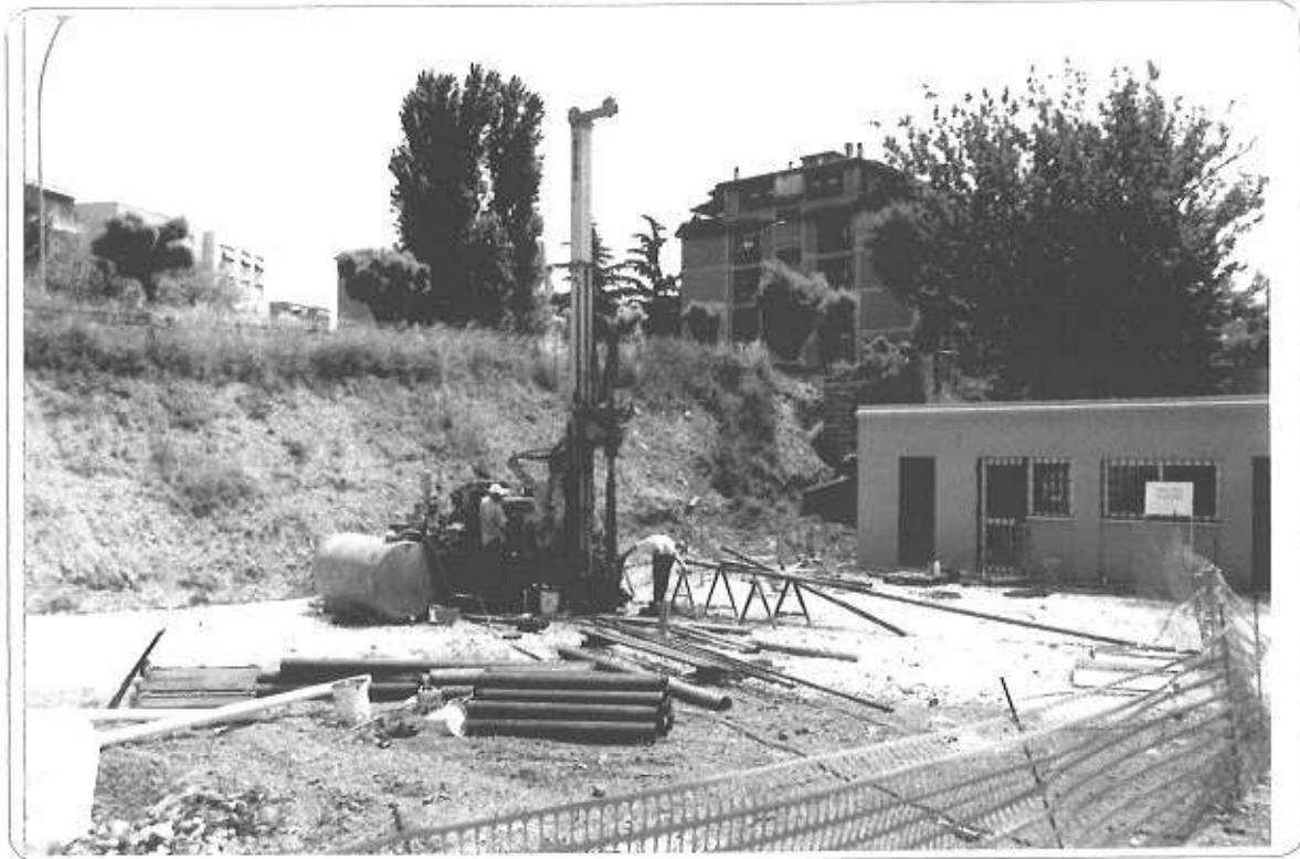
sondaggio meccanico S1
