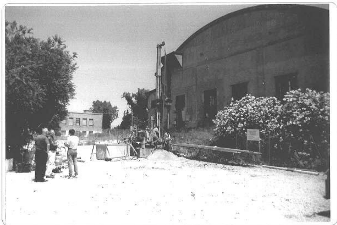
sondaggio meccanico S2
