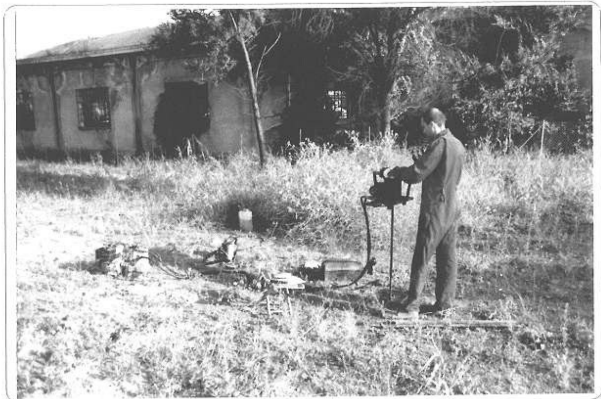
esecuzione di prove penetrometriche dinamiche continue
