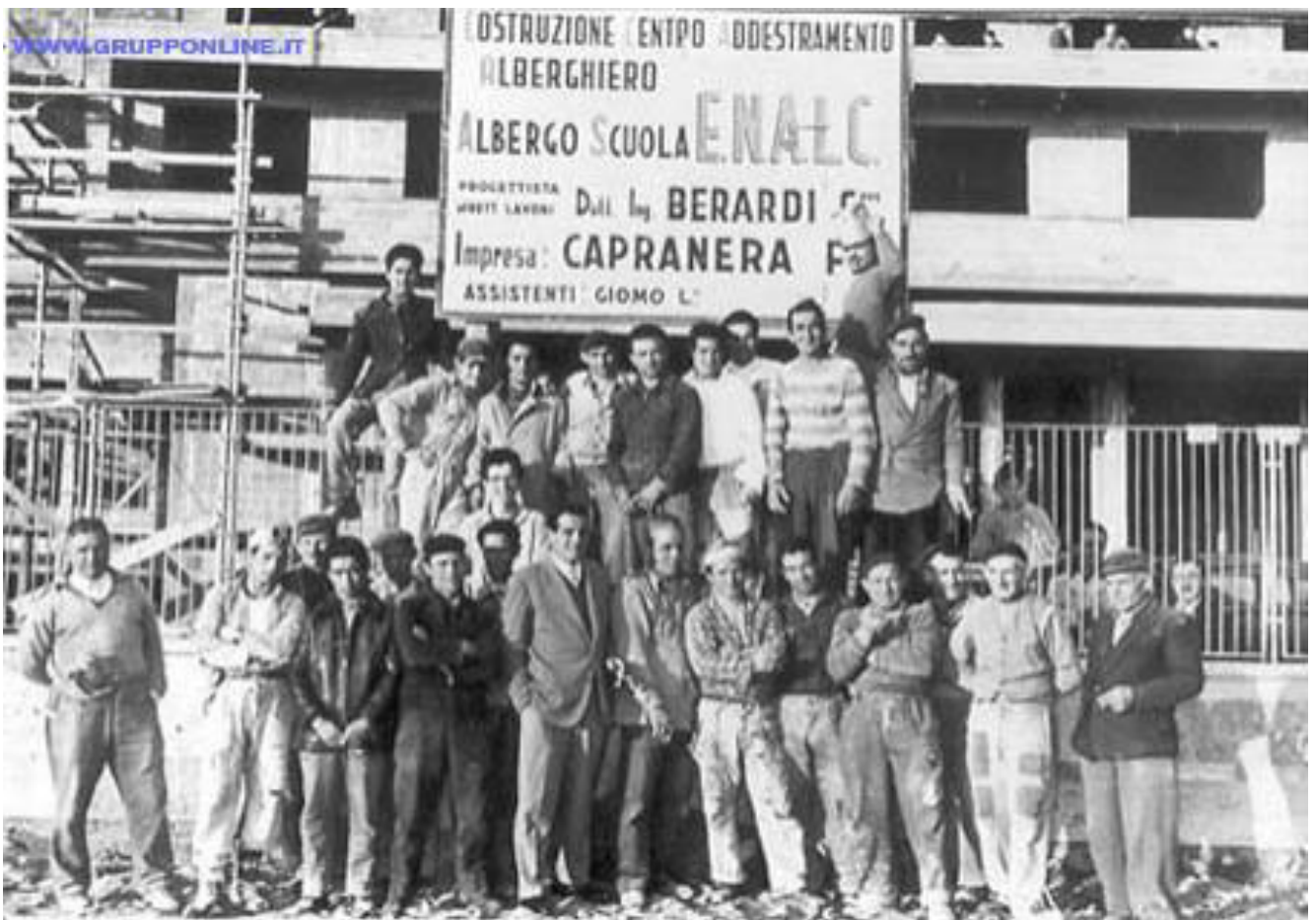
Foto del 1958 in ricordo degli operai che lavorarono alla costruzione del Centro Addestramento Alberghiero
