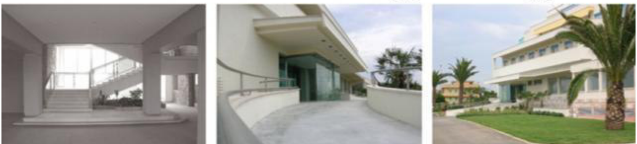
Progetto Pietro Renzi Architetti Associati per la nuova rampa di accesso (2011)
